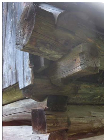
ULOŽENIE KROKEVNICE A KROKVV
