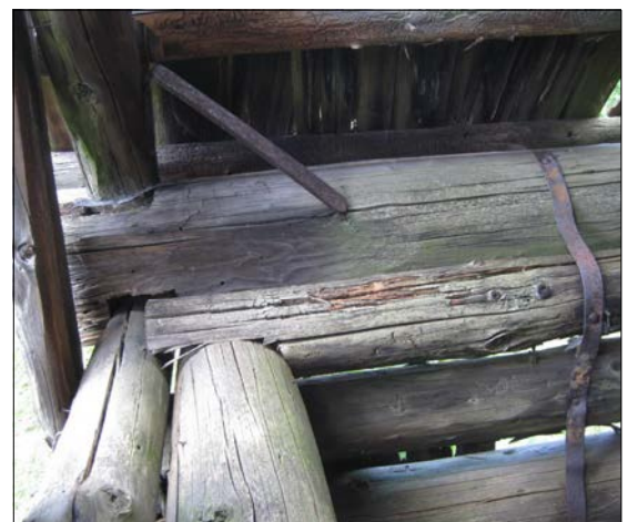
DETAIL PRI ŠTÍTE _ DODATOČNÉ SPEVNENIA
