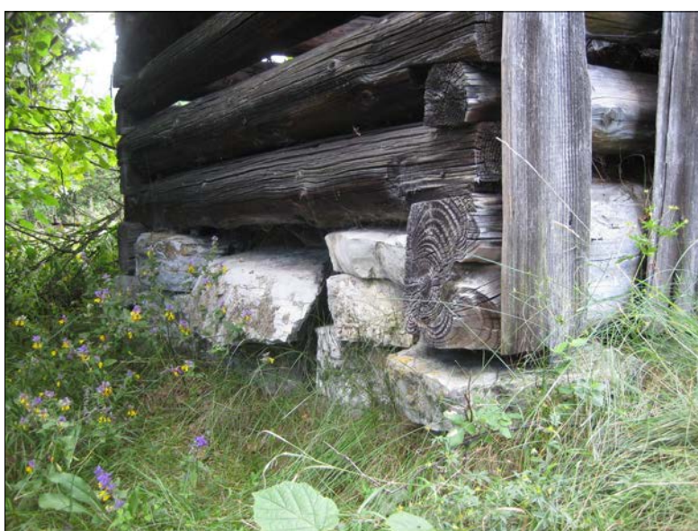
DETAIL ZRUBOVEJ STENY PRI ZÁKLADOCH
