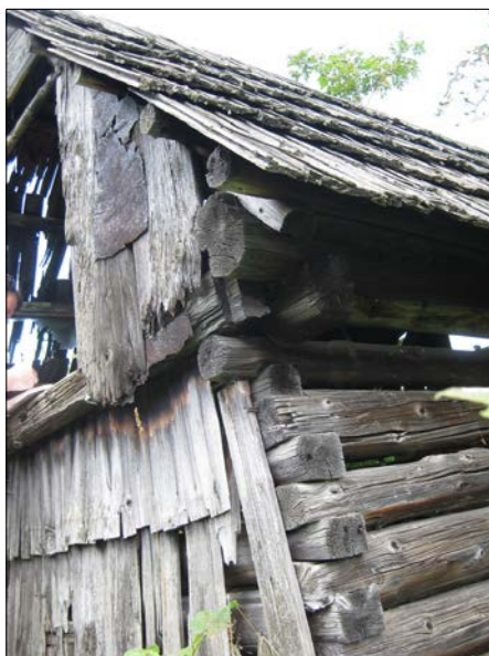
PŮVODNÉ OŠINDĽOVANIE PREDNEJ ČASTI
