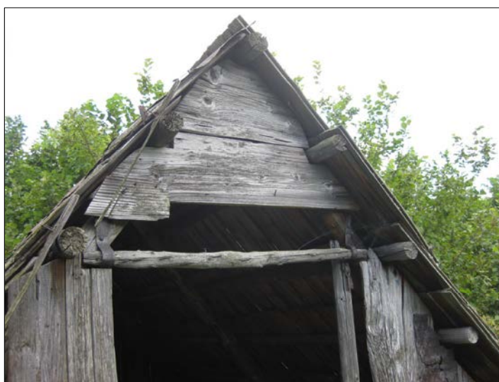
DREVENÝ PÁNT ŠTÍTOVÉHO OTVORU
