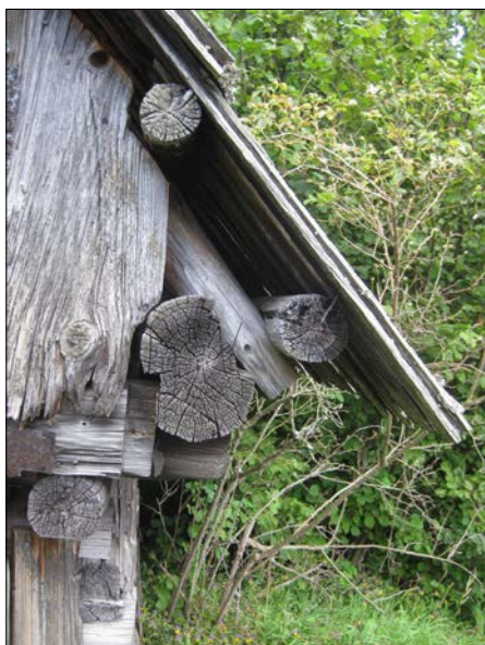
OKRAJ STRECHY PRI ŠTÍTE
