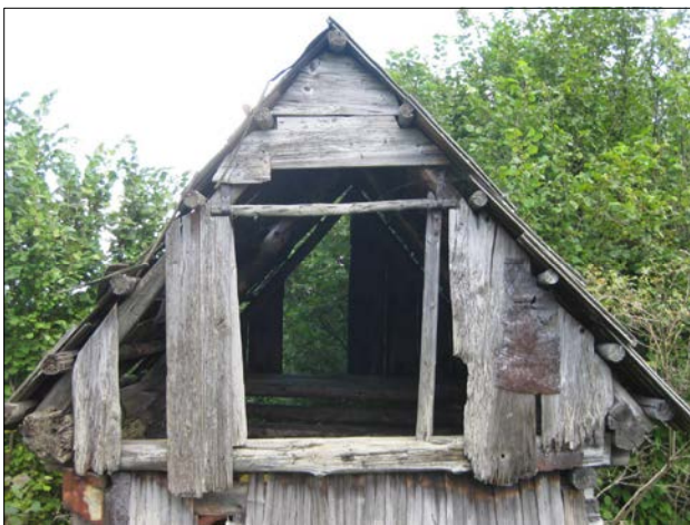
DETAIL ZÁPADNÉHO ŠTÍTU S TORZOM KONŠTRUKCIE OTVORU
