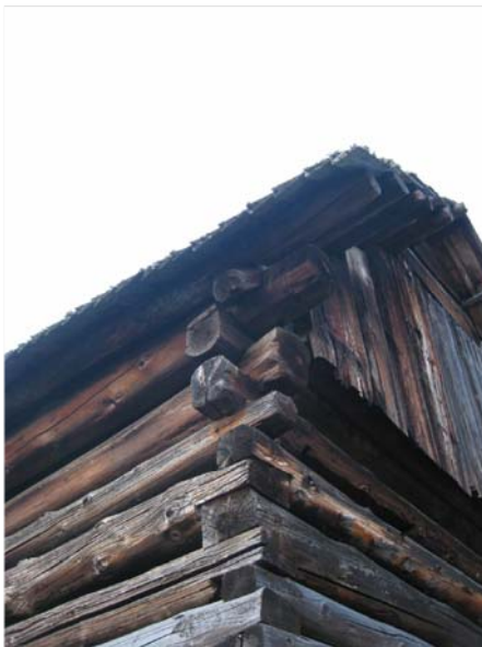
POHĽAD NA NÁROŽIE OD JUHOVÝCHODU
