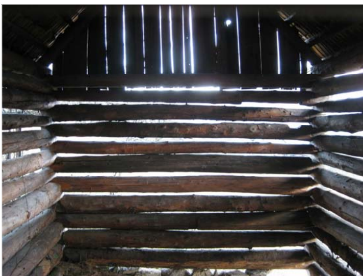
POHĽAD DO VNÚTRA SENNÍKA
