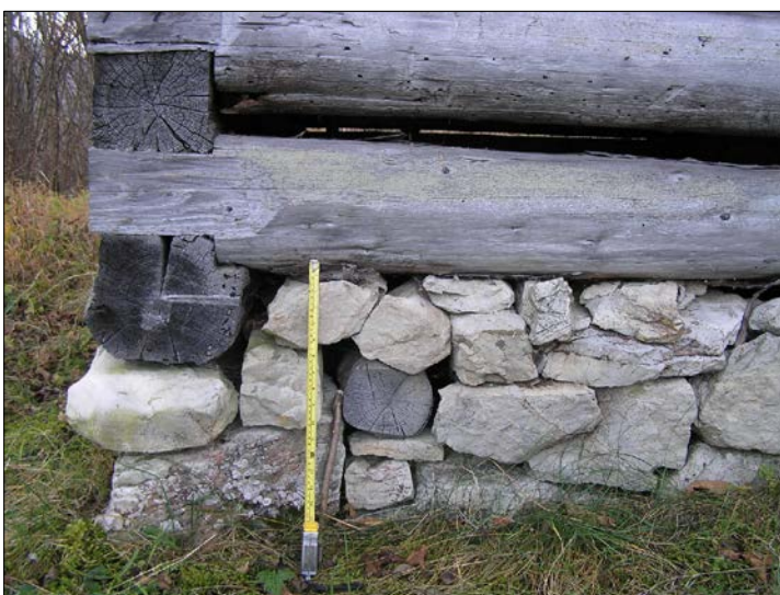
ZÁKLADY Z VÁPENCOVÝCH KAMEŇOV
