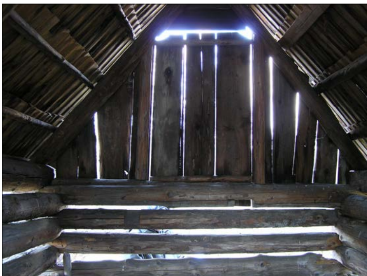
VNÚTORNÝ POHĽAD NA JUŽNÝ ŠTÍT
