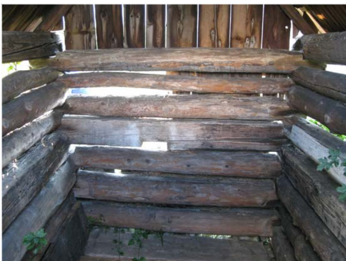
POHĽAD NA ULOŽENIE TRÁMOV A PODLAHY Z VNÚTRA SENNÍKA
